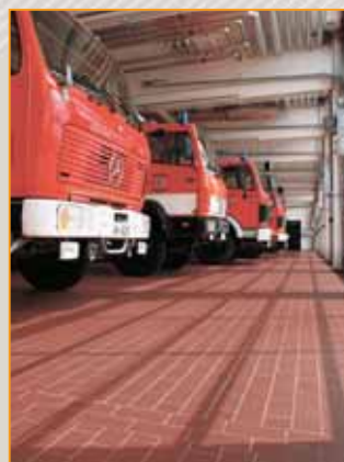
posadzka wykonana z płytek Argelith
