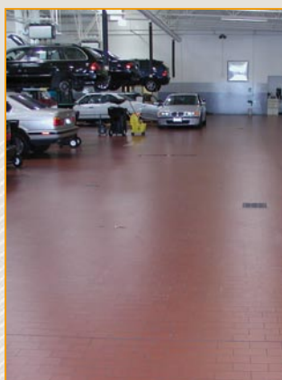
Fußboden hergestellt aus Argelith-Platten
