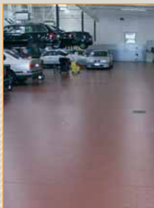
posadzka wykonana z płytek Argelith
