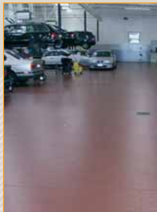
posadzka wykonana z płytek Argelith
