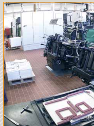
posadzka wykonana z płytek Argelith
